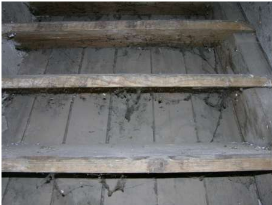
Pohled na schodiště – detail podbití
