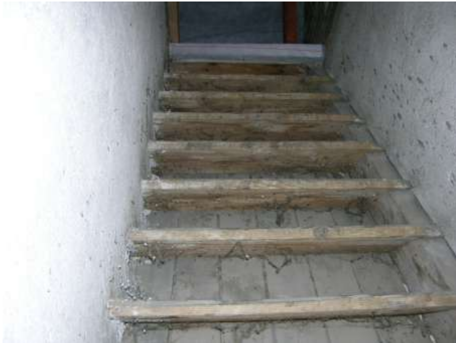
Pohled na schodiště zespodu, nahoře půda (85 x 350 cm)
