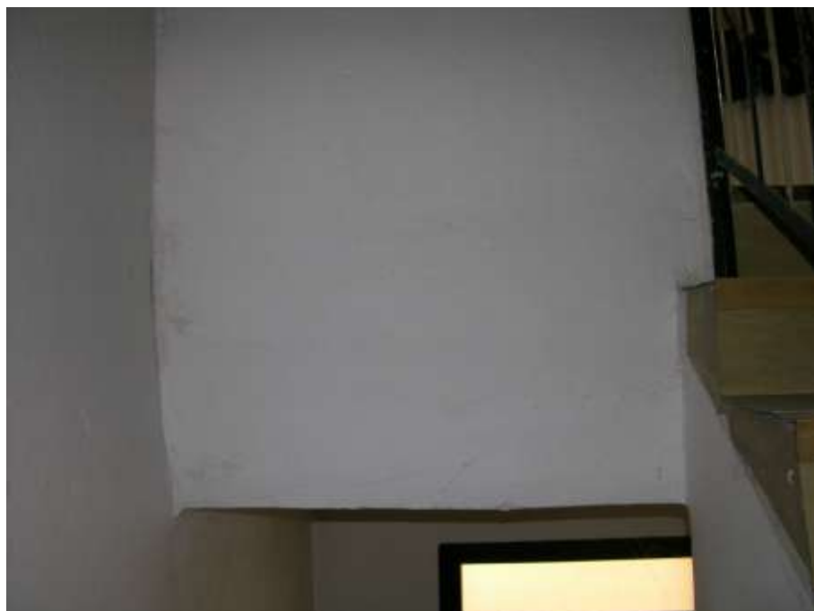
Vnější pohled na schodiště – zespoda ze spodního schodiště domu (spodní část schodiště)
