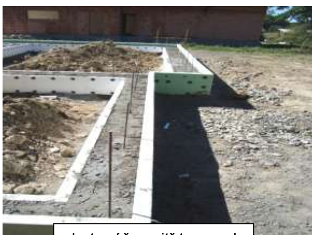
betonáž uvnitř tvarovek
