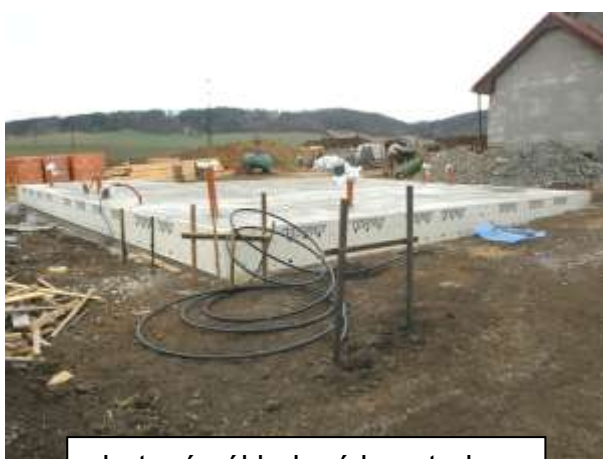
hotové základové konstrukce
