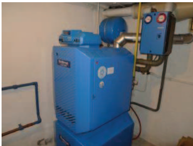
erneuerter Heizkessel
