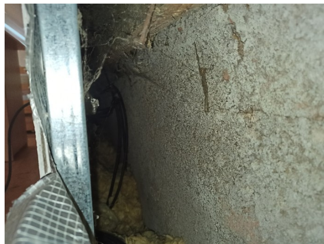
foto/10/ Pohled do dutiny za svislou SDK konstrukcí
