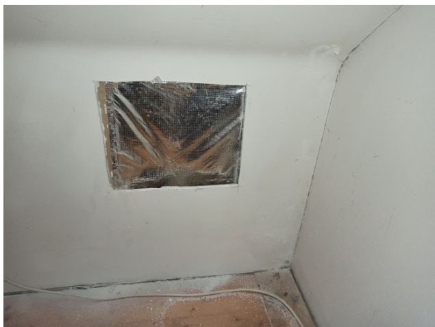
foto/7/ Pohled na provedenou sondu S1
