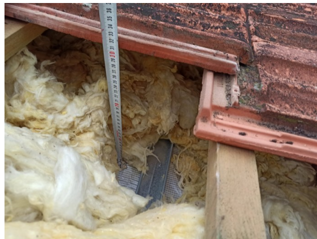
foto/12/ Pohled na provedenou sondu S2
