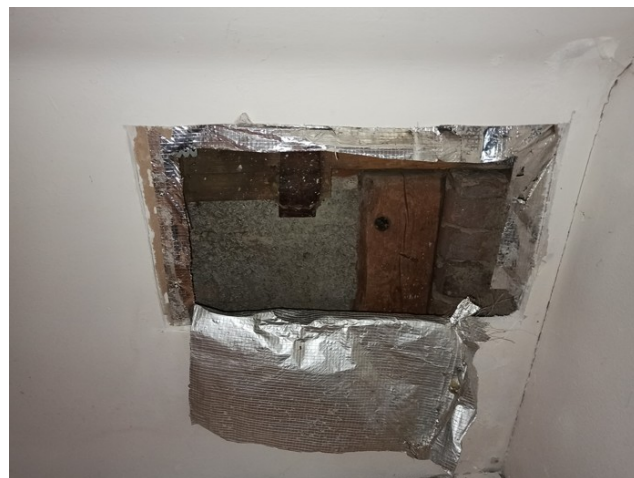
foto/8/ Pohled na provedenou sondu S1
