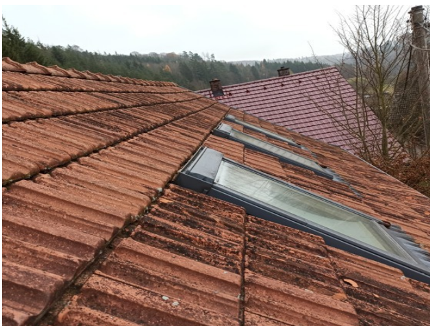
foto/3/ Pohled na předmětnou střešku
