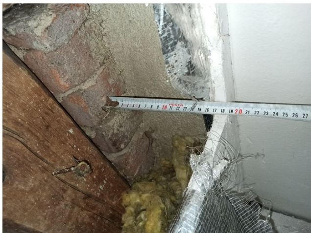
foto/9/ Pohled na provedenou sondu S1
