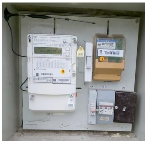
Příklad opravy z nevyhovujícího sloupku na vyhovující: nový elektroměr, nové HDO, nové oddělovací relé
