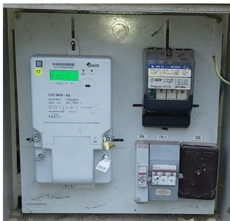
Příklad opravy z nevyhovujícího sloupku na vyhovující: nový elektroměr, nové HDO, nové oddělovací relé
