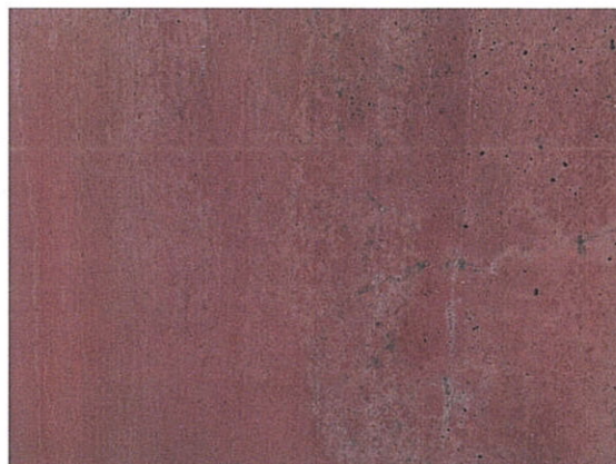
Hladká stěna od formy
