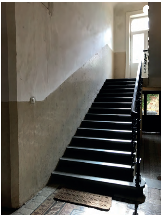
1. c- Chodba - linkrusta na zdech a omítky
