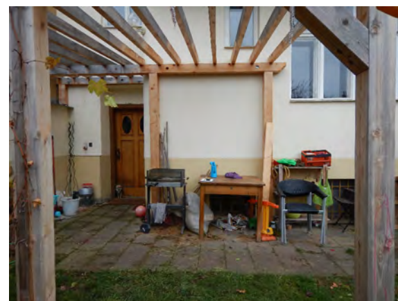
přístavba terasy, Brno Hutařova
