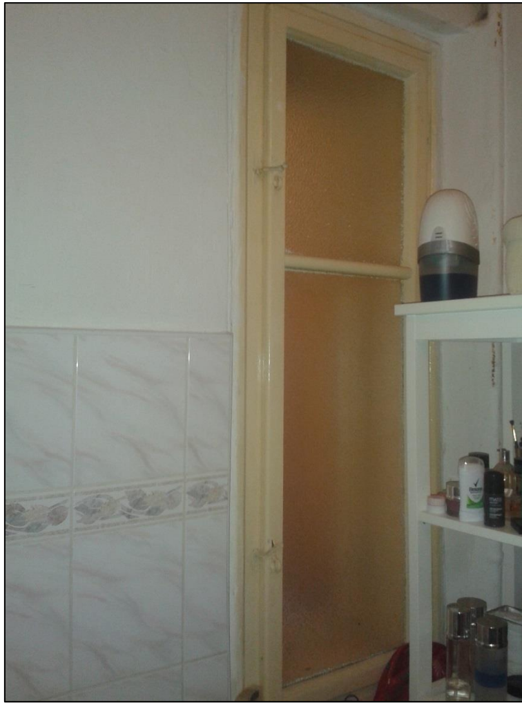
Obr. 35: Okno v koupelně
