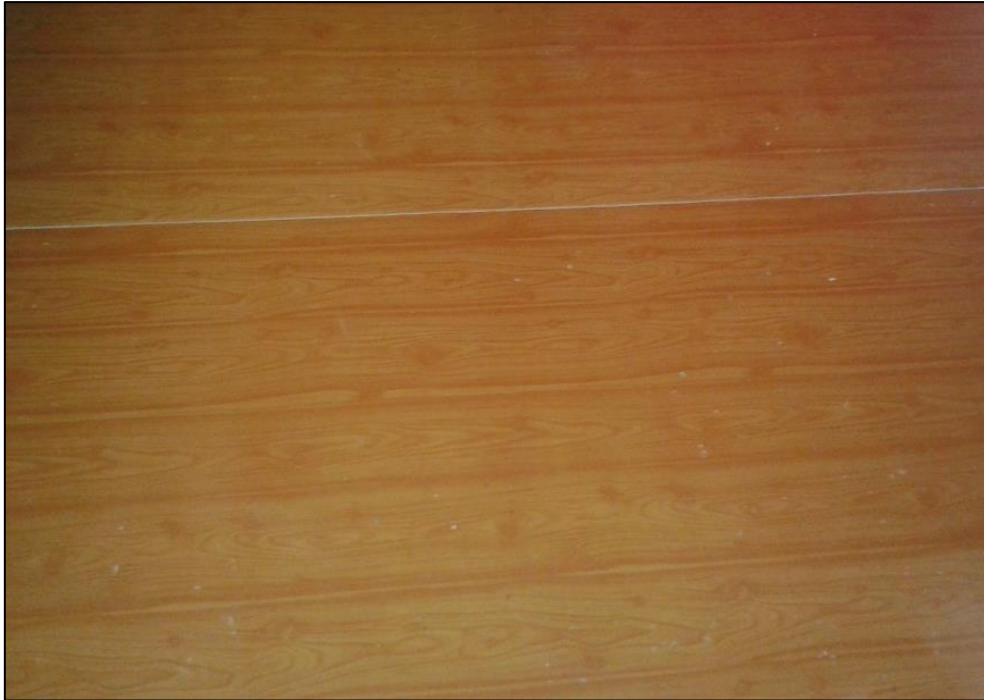
Obr. 16: Stávající podlaha v kuchyni
